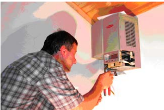
Montage Wechselrichter, Foto "die umweltberatung"
